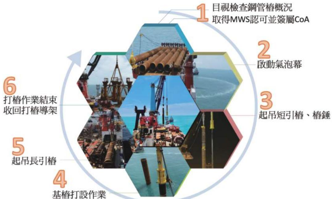
圖 4 基樁打設作業流程圖
