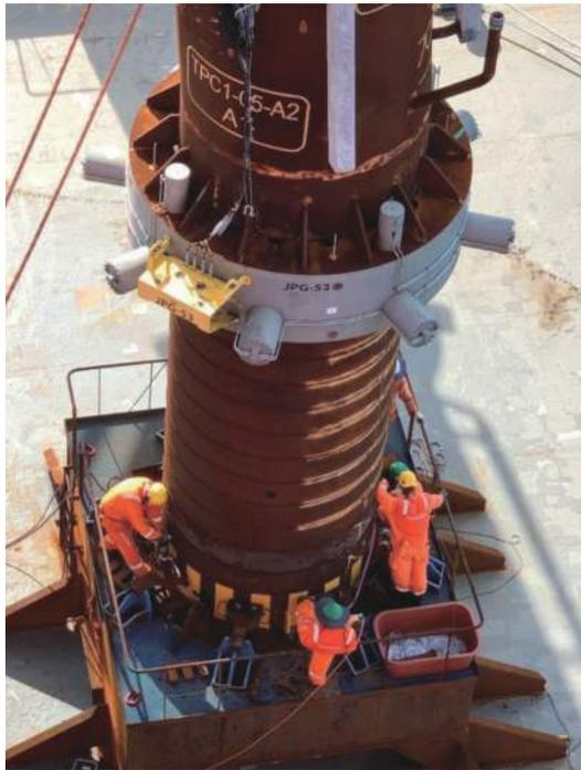
圖 5 套筒桁架抱樁器
