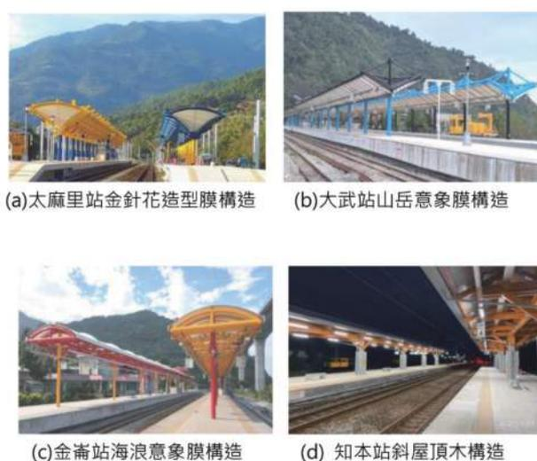
圖 32 南迴線車站雨棚造型
