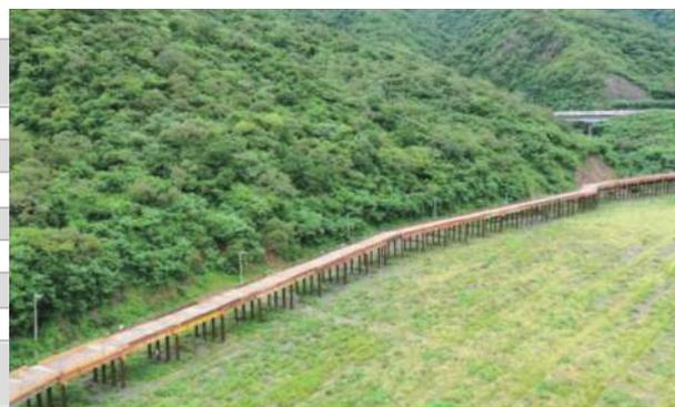
圖 30 枋山溪施工鋼棧橋
