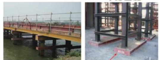
圖 18 施工構台柱基礎型式
