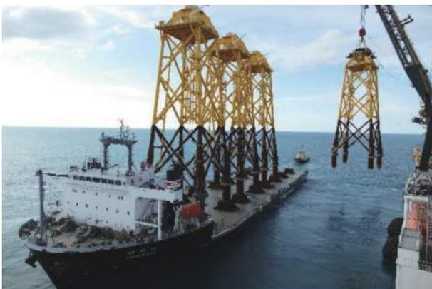
圖 6 吊裝套筒桁架過程
