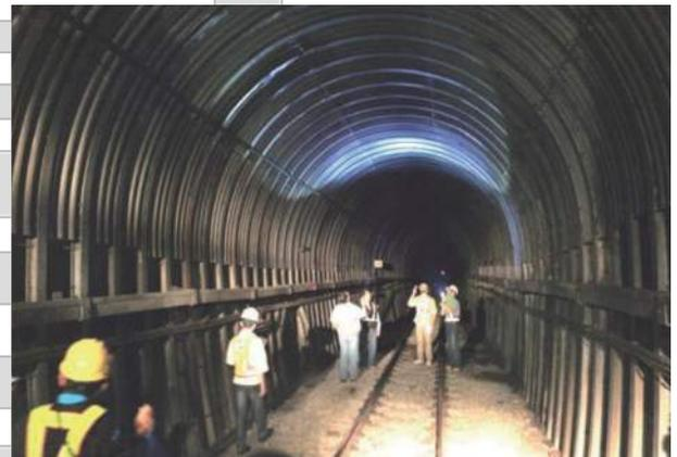
圖 8 多良一號隧道鋼肋補強及淨空不足情形
