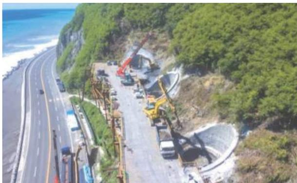
圖 18 多良改線段井式基礎竹削擋土結構
