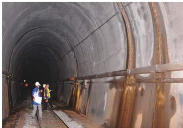
圖 6 金崙隧道內滲漏水情形
