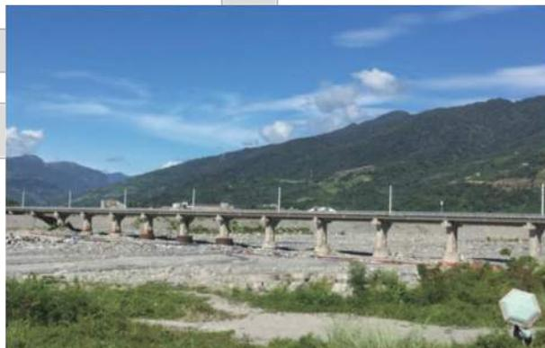
圖 20 利嘉溪橋基礎裸露及下游貨櫃固床工
