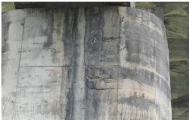
圖 4 加津林橋橋墩混凝土剝落及鋼筋銹蝕情形
