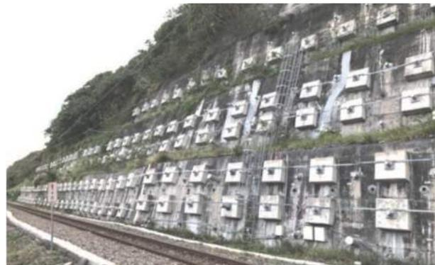
圖 12 富山邊坡補強後情形
