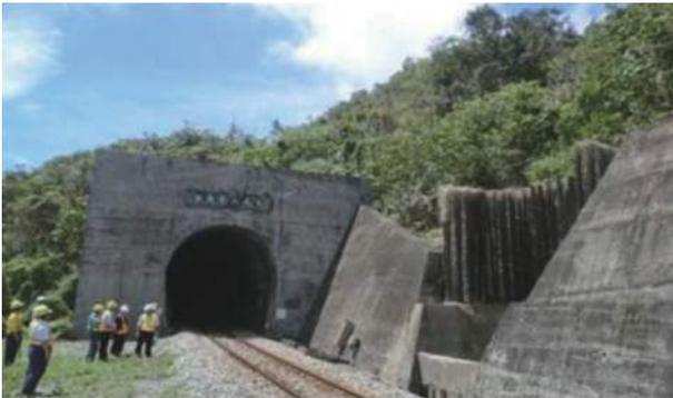
圖 9 大武二號隧道北口蝕溝保護設施
