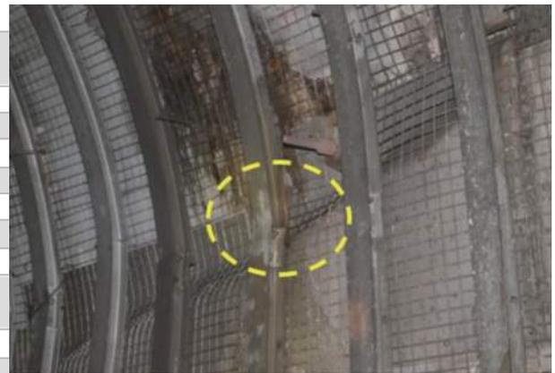
圖 15 多良一號隧道鋼支保挫曲變形情形
