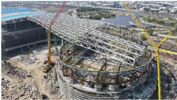
圖 6 會議棟及 TREEGATE 屋頂桁架吊裝
