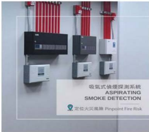
圖 12 吸氣式氣體探測器
