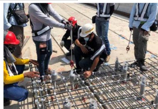
照片3 基鈹螺栓預留孔高程檢測
