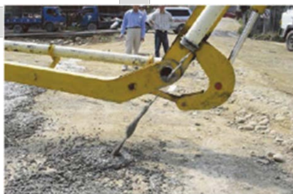
圖 2 國 6 石灼巷跨越橋輕質混凝土泵送塞管
