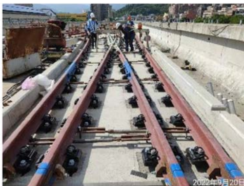
照片 8 特殊軌導軌段調整架安裝
