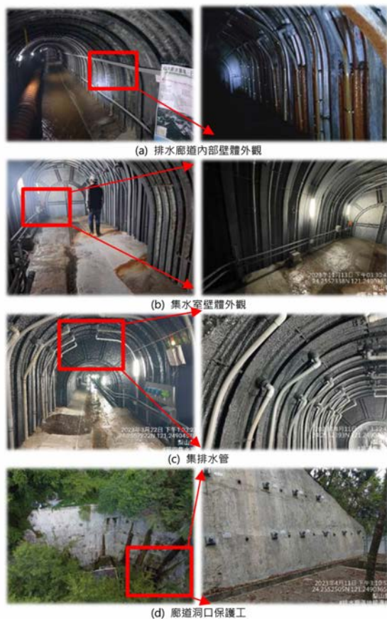
圖 8 排水廊道檢查項目照片
