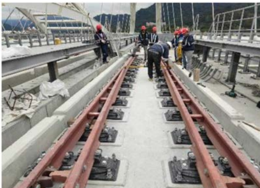
照片 19 特殊軌鋼軌安裝及線形調整
