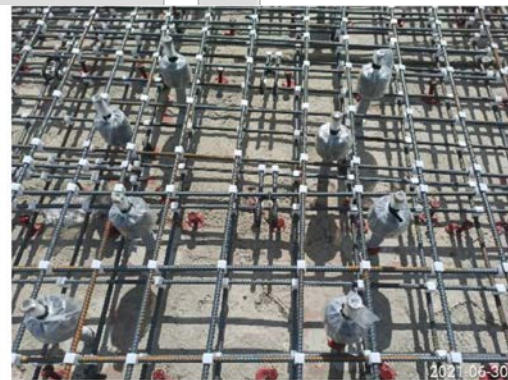
照片2 基鈹螺栓預留孔施作完成
