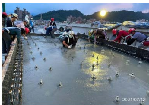
照片 6 特殊軌道床版混凝土澆置
