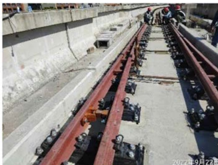
照片 9 特殊軌尖軌段調整架安裝
