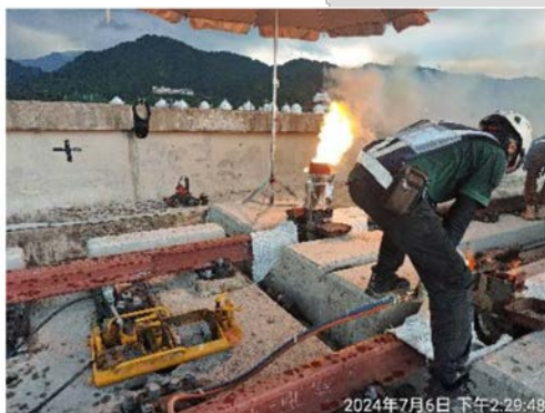
照片 20 特殊軌鋼軌接頭處鋁熱銲
