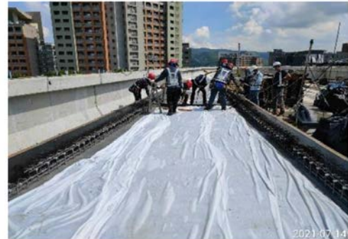
照片 7 特殊軌道床版混凝土養護
