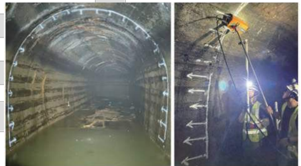
圖 5 桃園大圳第三號隧道內透地雷達檢測實況（本團隊拍攝）
