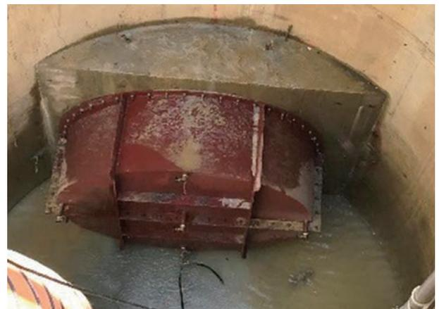
圖 16 鋼製止水箱裝設照片
