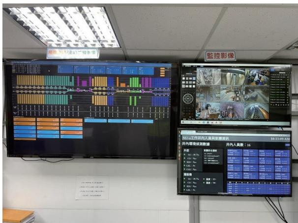
圖 21 局限空間即時定位與生命徵象監控系統
