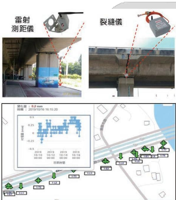
圖 10 無線自動化監測儀器及即時雲端數據
