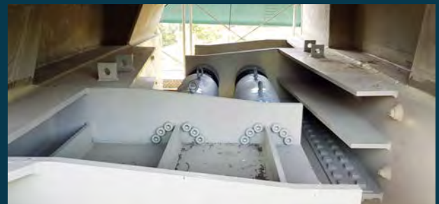
高鐵里程TK312橋梁改善工程
