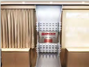
中興大業大廈耐震性能提升工程
