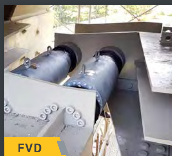
FVD 高鐵公司_T1-19-009標 高鐵里程TK312橋梁改善工程
