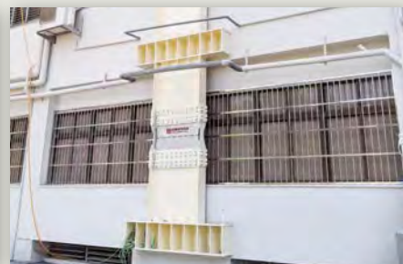
蘆洲區長安公有零售市場耐震補強
