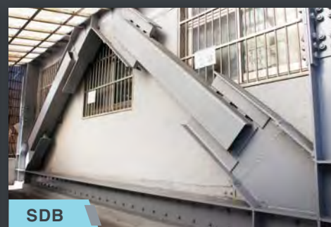
SDB 瑞芳礦場保安中心辦公廳舍結構補強 及防水整修工程
