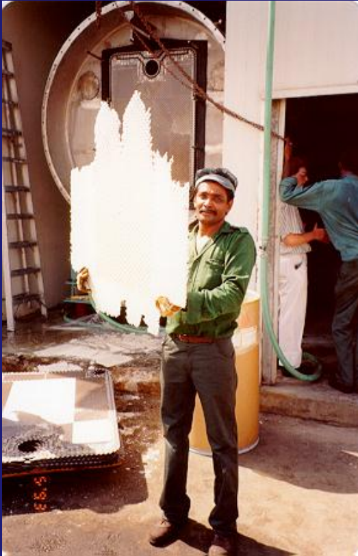
現場操作人員輕易將塊狀水垢(CaSO4)剝除
